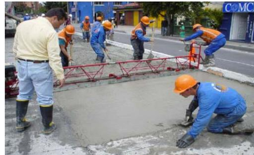
Una vez colocado, extendido y vibrado el concreto se procederá con el respectivo acabado y texturizado superficial con costal de fique y rastrillo (cepillo).
